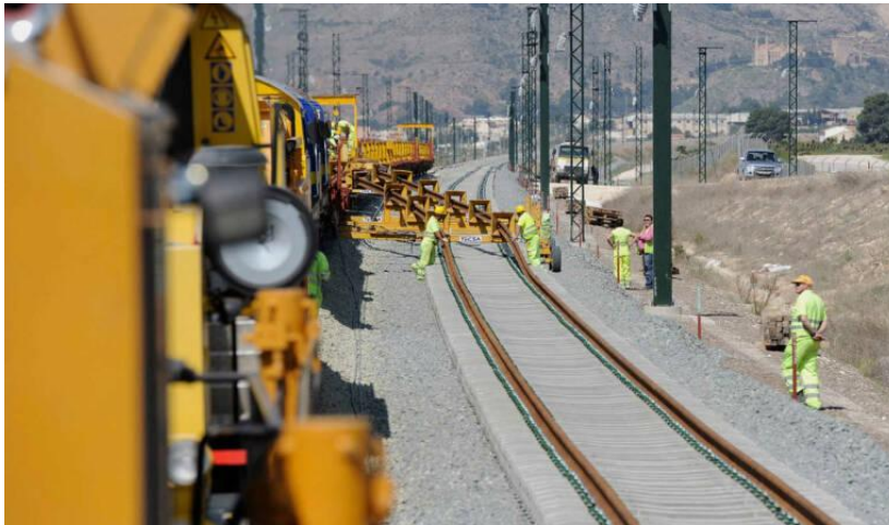
Una obra para implantar el ancho internacional ferroviario. Foto: RAFA MOLINA
